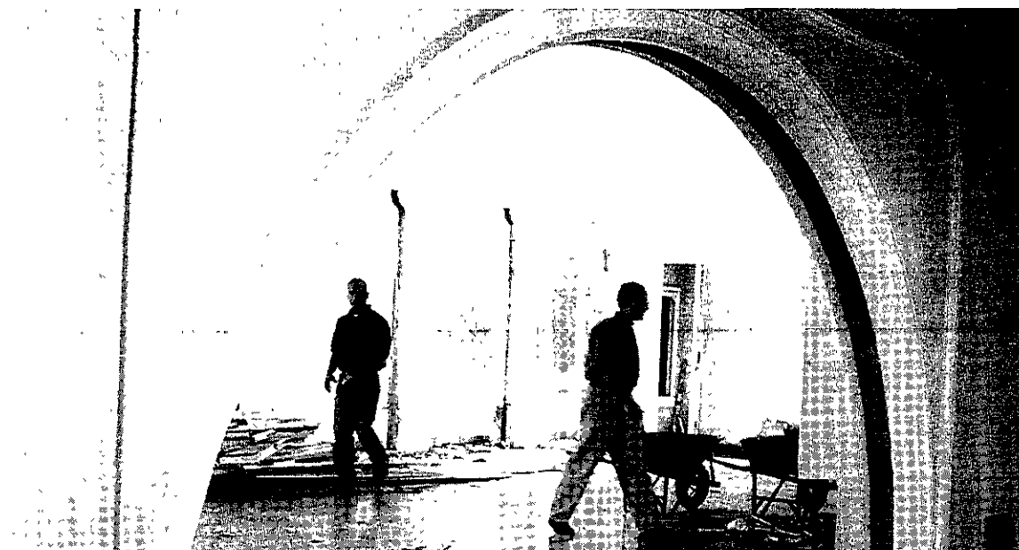
Vista de una parte de los trabajos de remodelación y recuperación de los espacios originales en las planta física de la Cancillería de la República Dominicana
